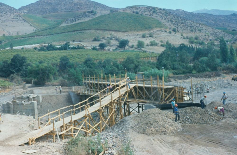
CONSTRUCCIÓN DEL PUENTE LOS MORALES, CHAÑARAL ALTO Abril de 1996.
